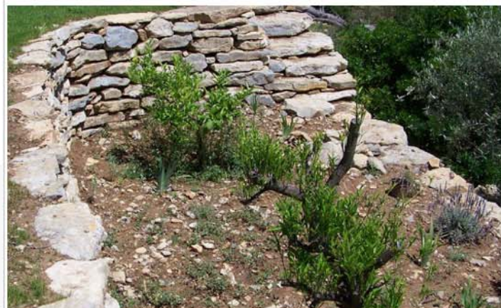
Restanques avec moyet et faible dénivelé, ayant une vocation décorative, (2, 5 tonnes de rocher par m2)
